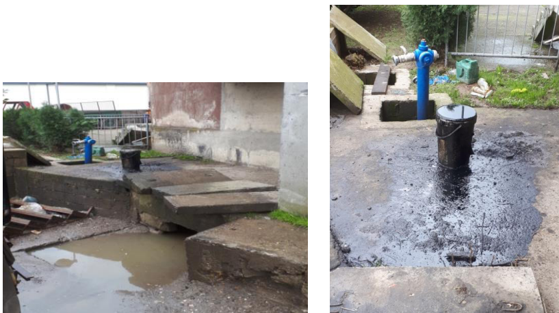
Слика 4.4-3 Место за прање механизације, са сепаратором за масти и уља
