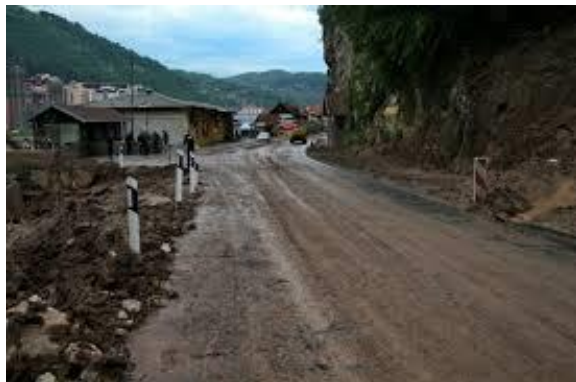
Слика 40: Клизиште изнад државног пута бр 1Б У Малом Зворнику оштетило пут, гасовод, оптички кабл, водовод и засуло ток Дрине.
