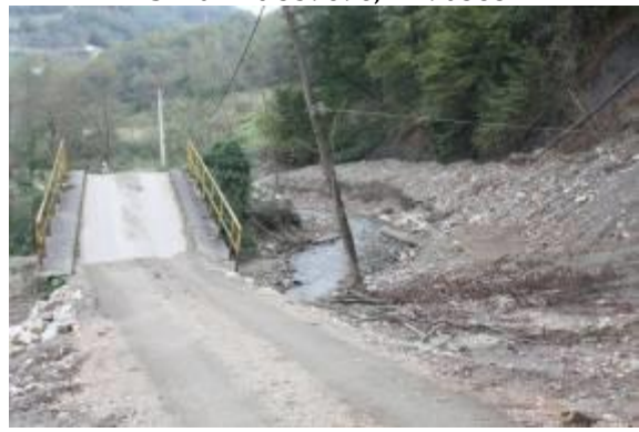
Слика 9. Велика Река – мост
