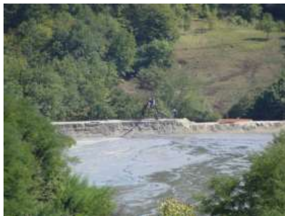
Слика ЕМР.11. Јаловиште и брана чија горња кота бране се осигурва и повишава
