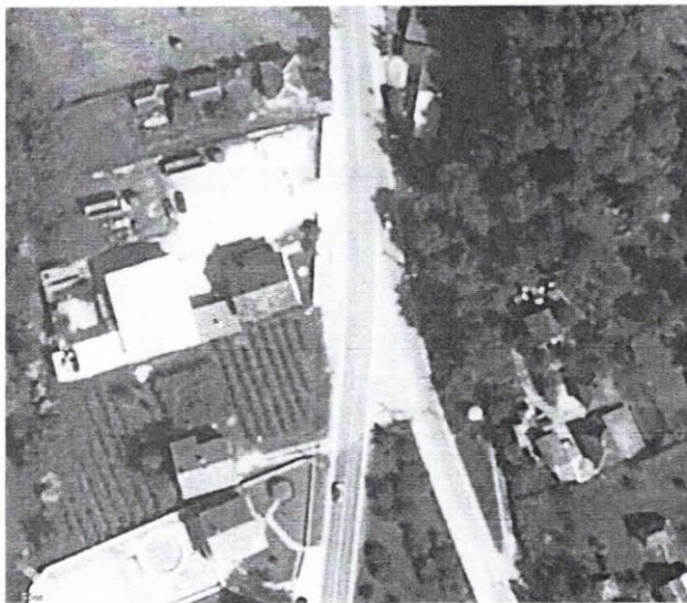
Слика 1. Постојеће стање раскрснице
